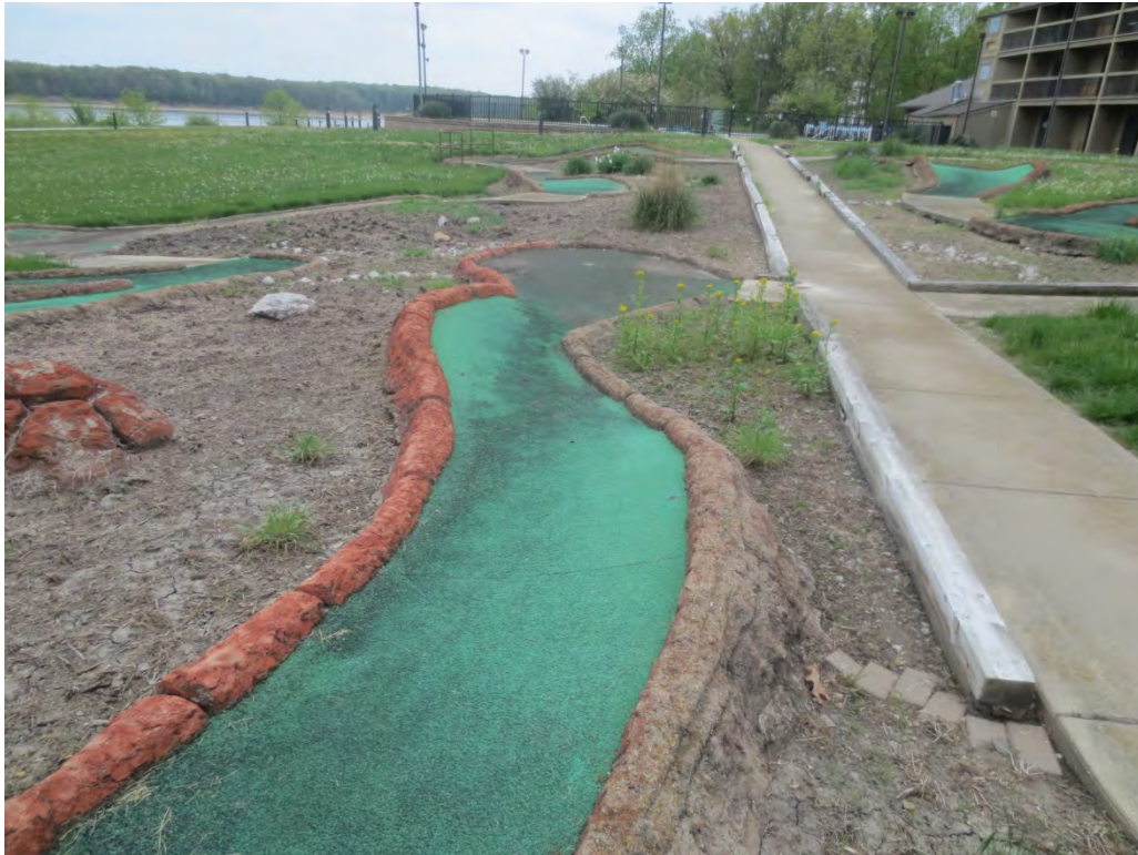
Mini golf area – typical condition*
